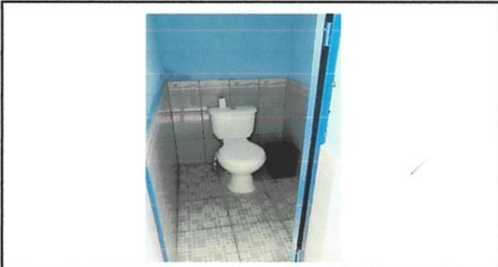
Foto 1: Sustitución de tasa sanitaria y colocación de piso antideslizante y azulejo en el baño.
